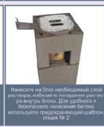
Установите бетонный блок на цементный раствор, проконтролируйте вертикальность с помощью уровня и залейте блок бетоном. Выждите 2 дня для схватывания бетона. Для быстрого монтажа используйте бетонный вкладыш, опция № 1
