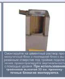
Нанесите на блок необходимый слой раствора, избегая попадания раствора внутрь блока. Для удобства и безопасности используйте предохраняющий шаблон, опция № 2
