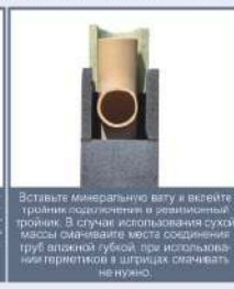
Установите ранее вырезанный под трюник ревизии блок на цементный раствор, проконтролируйте вертикальность с помощью уровня
